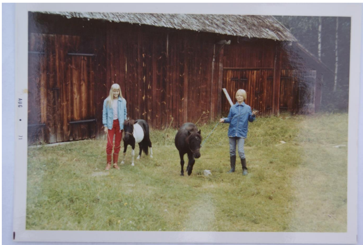
Döttrarna Hall vid ladugården som har spåntak
