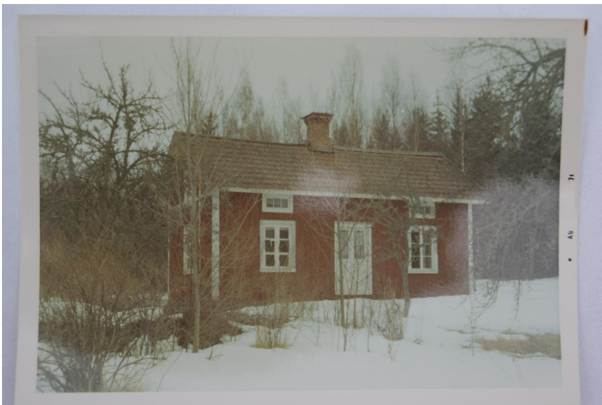
Finentrén utan veranda
