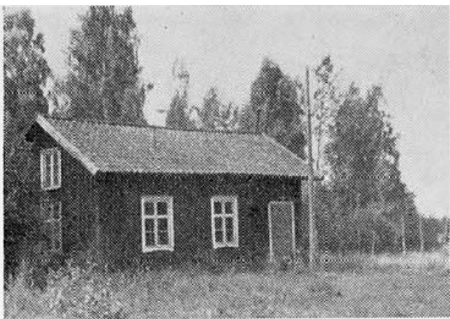
Delebäckstorp, Ordenshus, Hova: Trä, 1918, 2 samlingslokaler, 1 bibliotek, 1 kapprum samt 1 bost.läg. om 2 rum, 1 kök, 1 hall. El, v, avl, cv, vv, wc, badr. — Logen nr 1549 Frid av IOGT.
